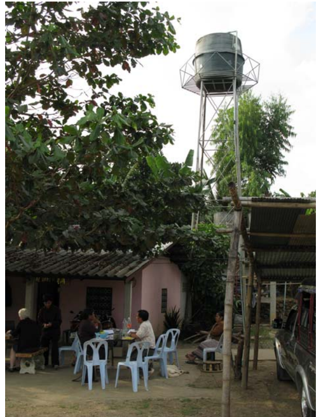
Der (undichte) Wassertank des Blessing Home
