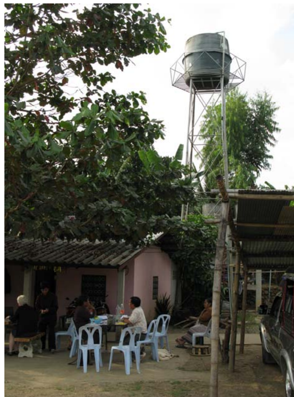
Der (undichte) Wassertank des Blessing Home
